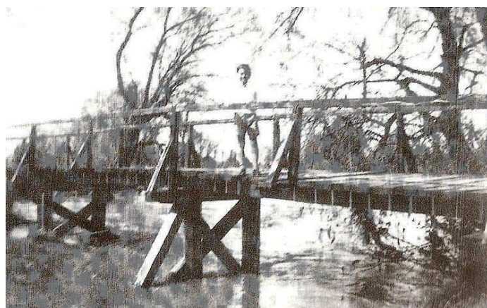
L'un des deux ponts encore en fonction en 1937
